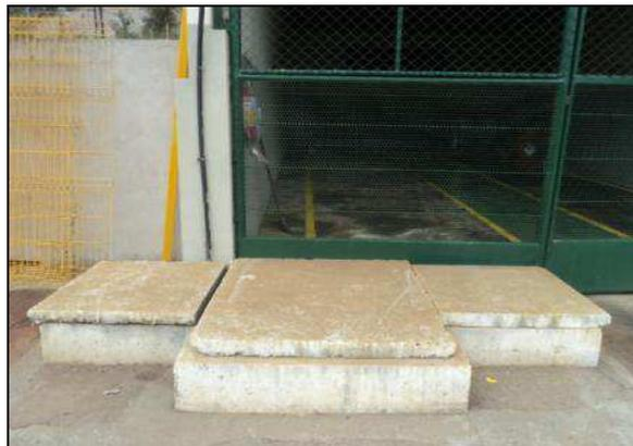
FIGURA 16- GALPÃO DE RESÍDUOS OLEOSOS – CAIXA SEPARADORA DE ÁGUA E ÓLEO
