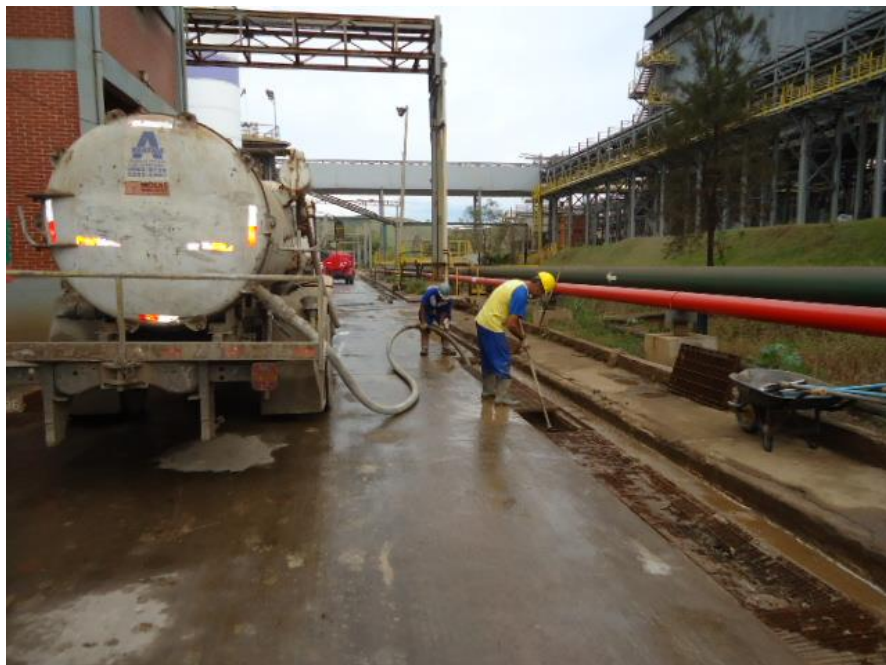
Figura7: Limpeza de canaletas na área industrial. Autor Welliton C.M. de Paula. Mai/13.
