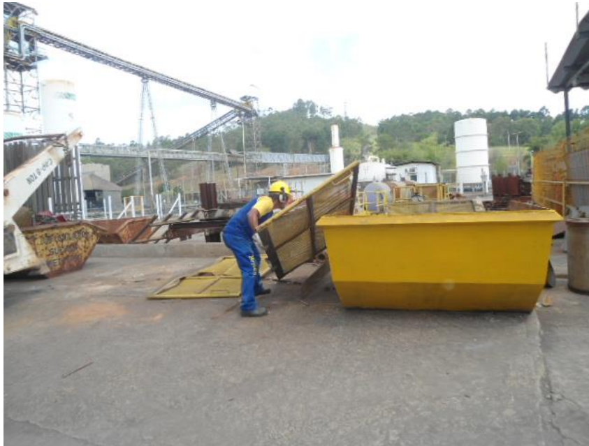
Figura 5: Retirada de sucata de ferro não contaminada da área. Welliton C. M. de Paula. Mai/2013
