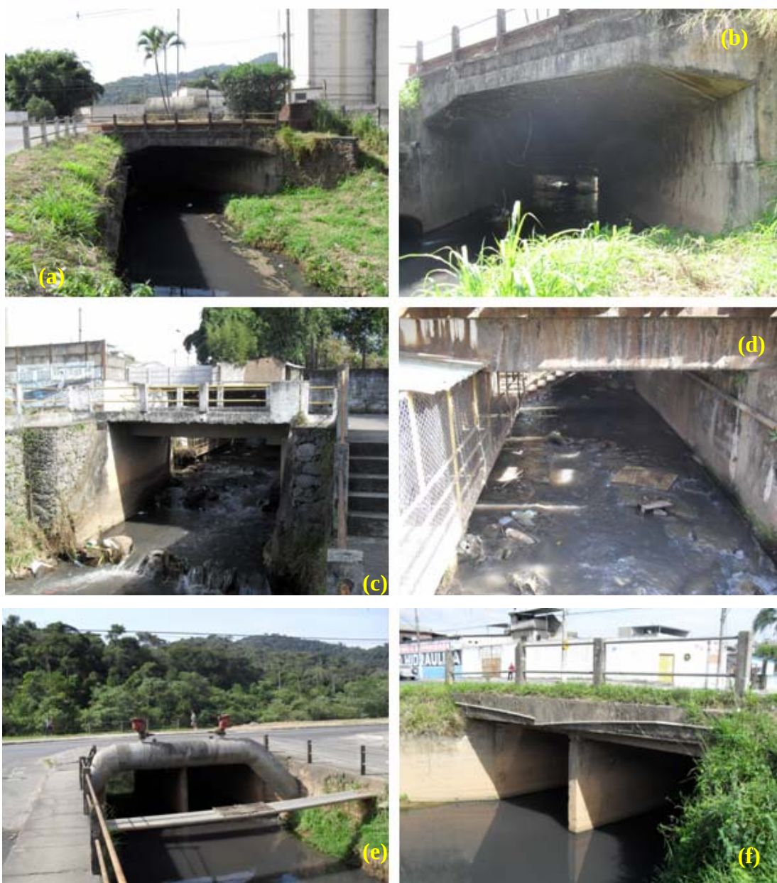
Figura V.5 – Obras de arte corrente do córrego Humaitá responsáveis pela travessia sob: (a) e (b) Avenida JF; (c) e (d) Ferrovia da MRS; (e) e (f) Avenida Brasil.
