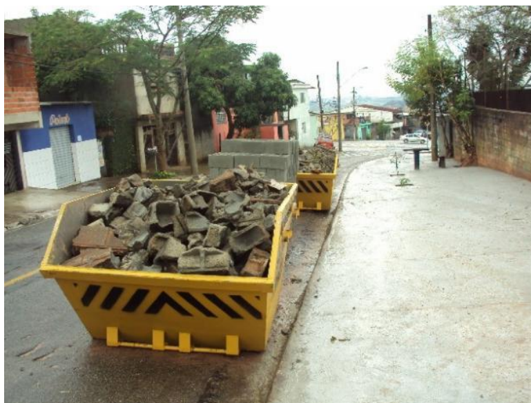
Figura 4: Caçamba para coleta de entulho.
