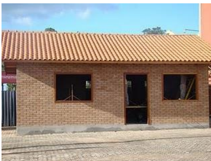
Figura 3: Residência construída com apenas restos de obras
