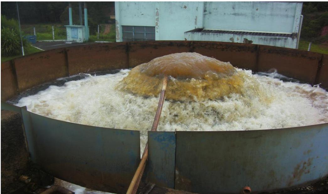
Figura 11: Tanque de aerador.
