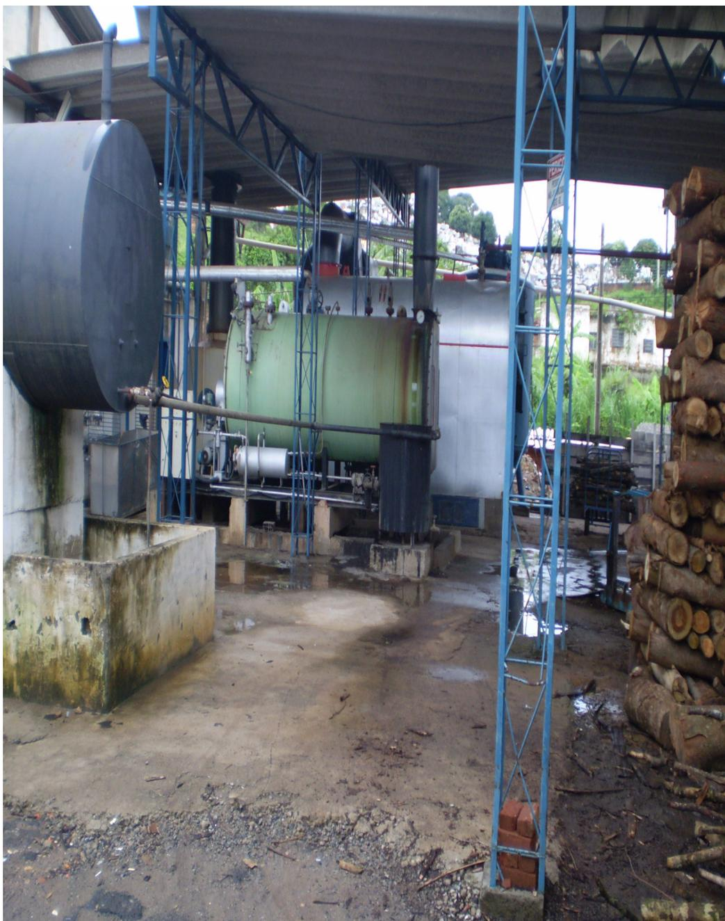
Figura 3 - Caldeira à lenha da empresa à direita e Caldeira a óleo á esquerda para quando necessária manutenção preventiva.
