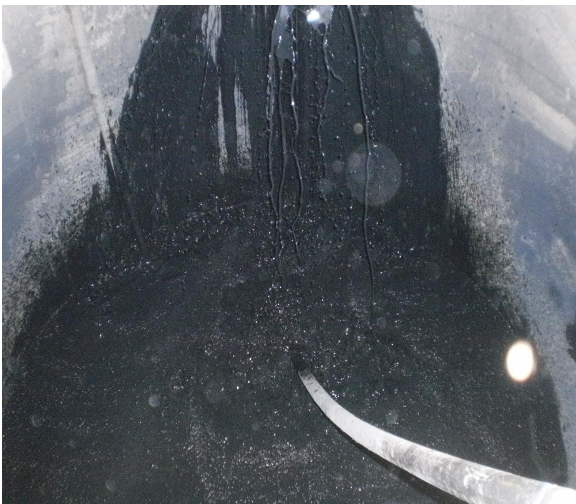
Figura 11 – Lodo sendo descarregado no reservatório de fibra de vidro.
