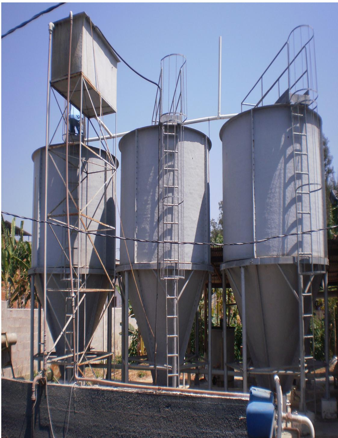
Figura 7 – Três decantadores tipo Dortmund.
