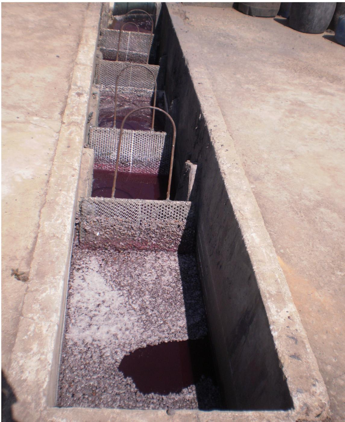
Figura 4 – Telas Grossas obstruindo a passagem de materiais sólidos, neste caso pedras cinasitas utilizadas para dar efeito de estonagem.
