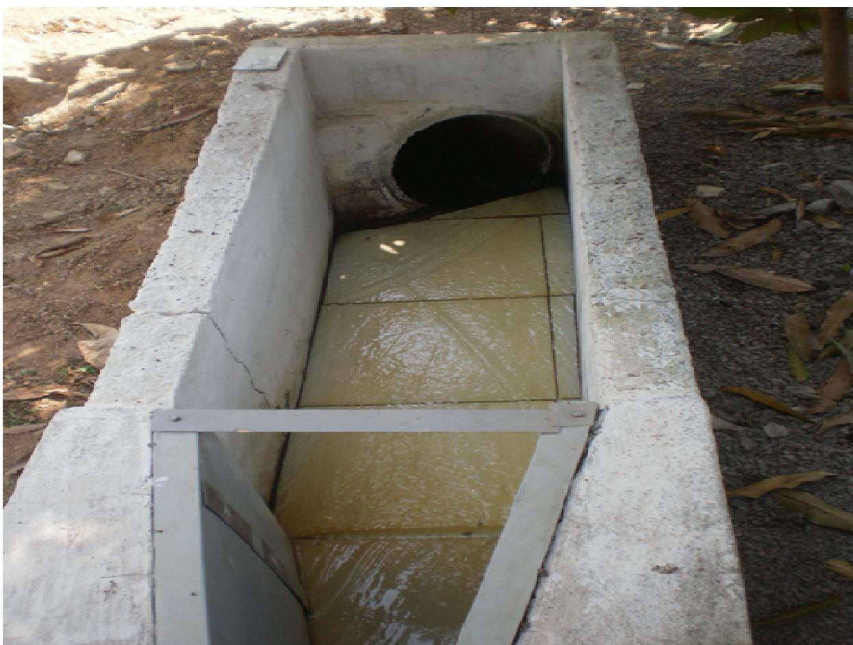
**Figura 9 – Saída o efluente já tratado na Calha Parshall.**
