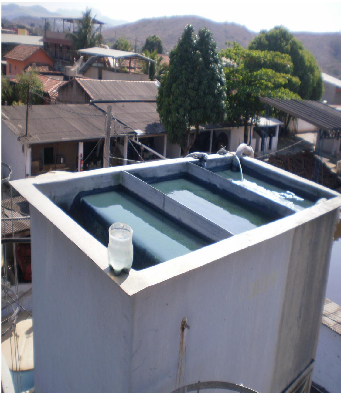
Figura 6 – Caixa de reação em funcionamento coagulação/floculação.
