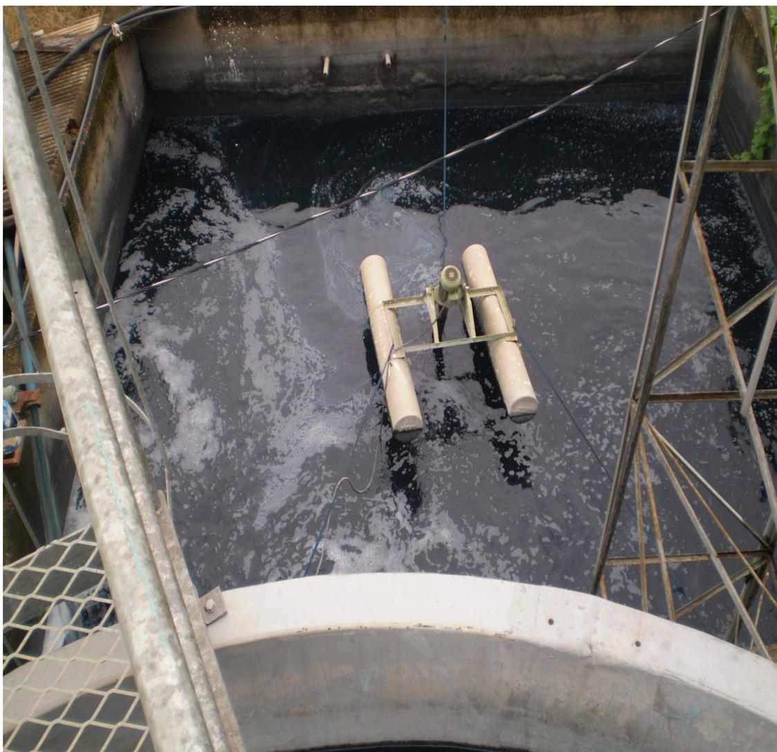
**Figura 5 – Homogeneizador em funcionamento no tanque de equalização**
