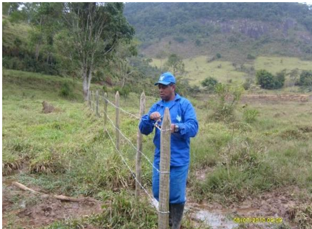
Figura nº8: Reforma de Cercas
