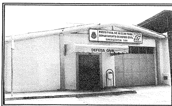
Figura 3: Fachada no ano de 1998.
