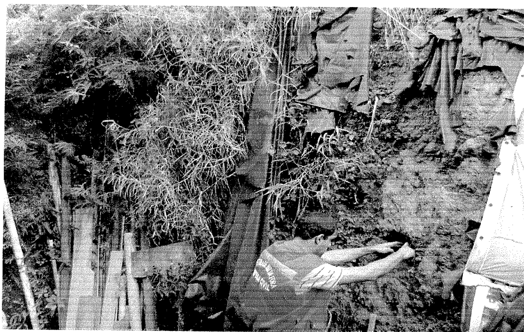
Figura 15: Introduzido o aparelho no talude.
