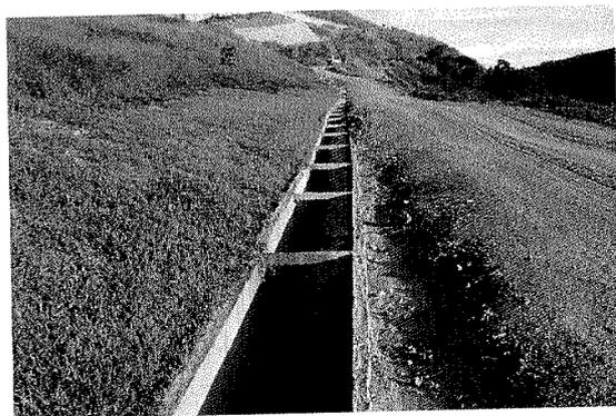
**Figura 3:** Canaleta de drenagem, de coleta de água de chuva e de animais mortos. Aterro de Juiz de Fora (foto dos autores).
