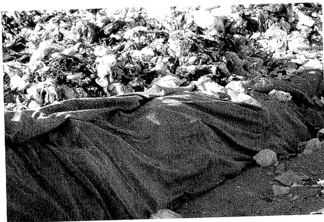
**Figura 7:** Preparo de nova camada de resíduos após colocação da manta PEAD no aterro de Juiz de Fora (foto dos autores).
