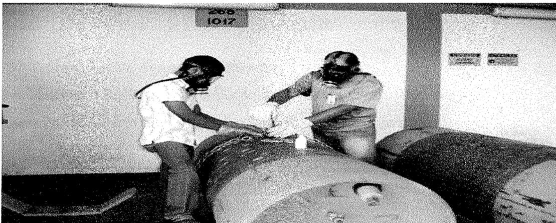
Ilustração 11 - Operação de troca do Cilindro de Cloro / ETA M.C.B.
