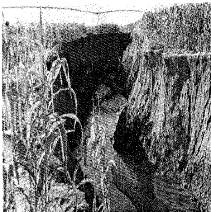
Fig. 2 - Erosão hídrica em propriedade rural. Fonte: http:// www.agr.feis.unesp.br/jr25022005.jpg
