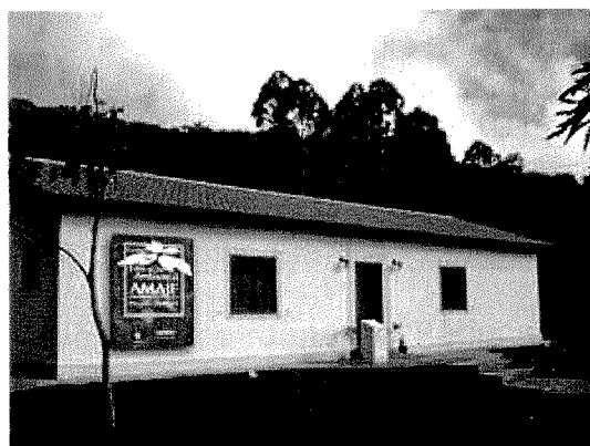
VISTA DA FACHADA CEA-AMAJF
