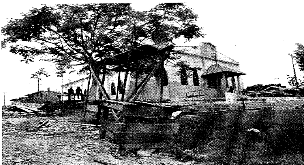
Figura 3 – Construção em ampliação Fonte: IEF, 2008
