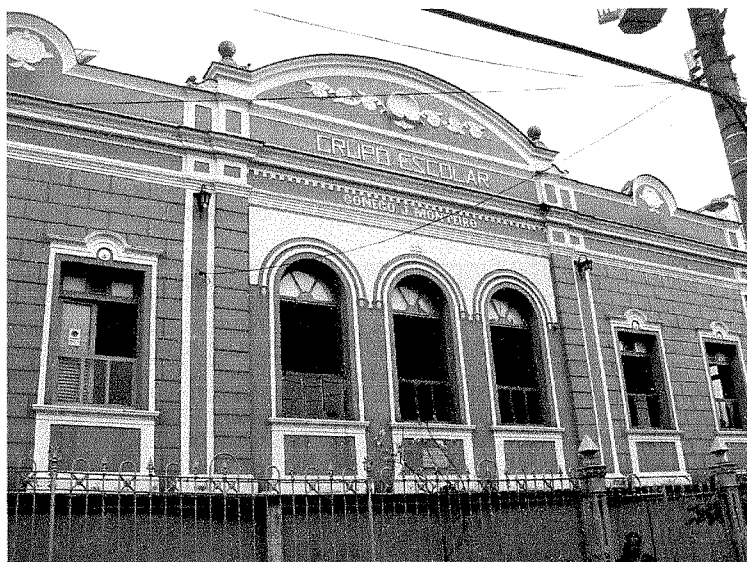
Fachada da Escola Estadual Cônego Joaquim Monteiro.
