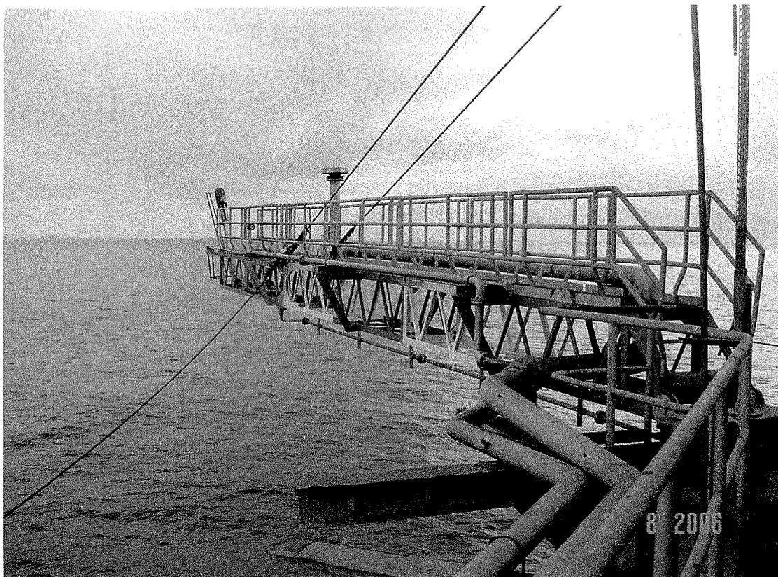
Figura 12: Queimador horizontal de plataforma petrolífera (Autoria própria)
