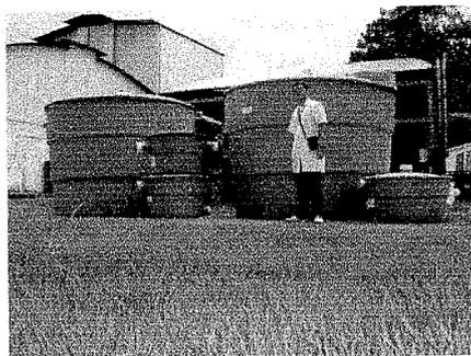
Figura 13 – Foto das caixas de tratamento de efluentes sanitários composta por filtro anaeróbio, caixa cloradora, caixa de gordura, fossa séptica e caixa gradeada respectivamente da esquerda para a direita.
