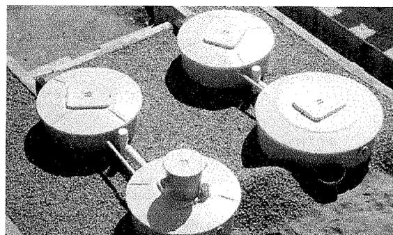
Figura 14: Tanque séptico e filtro anaeróbico em alvenaria
