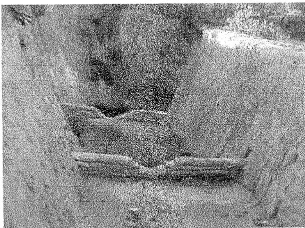
Figura 2: (Morro Cavado) - Falta de vegetação e contenção mal feita carregam para a nascente, todo o volume de material vindo da montante das nascentes
