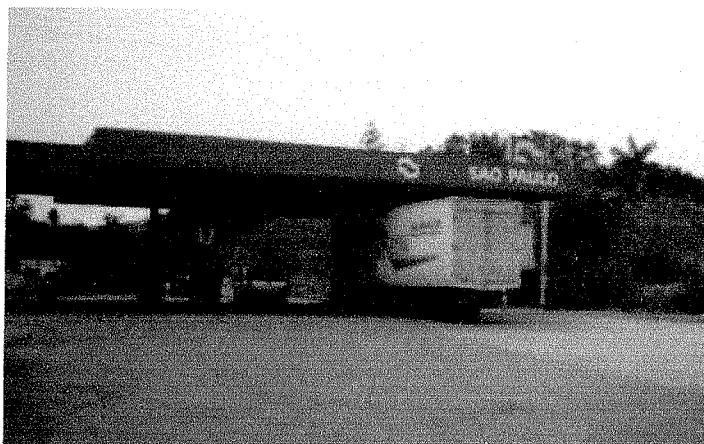
Foto 07 – Vista interna à área de abastecimento com detalhe para o piso impermeabilizado de concreto cimentado.
