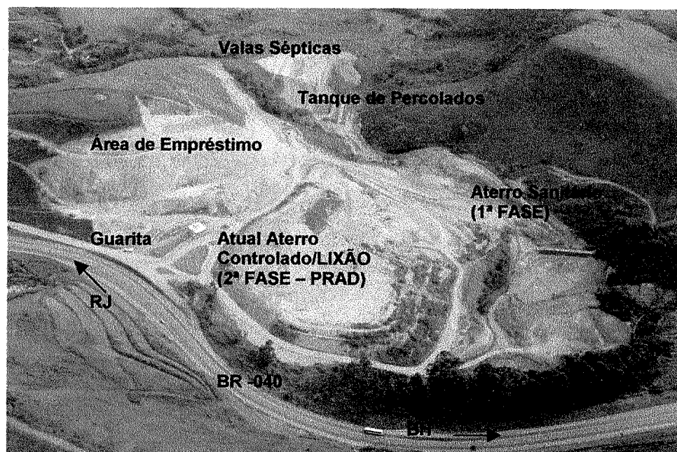
Fig. 03 – Área do Aterro Sanitário Salvaterra
