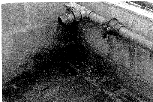
Figura 9 – Registro dos Leitos de Secagem
