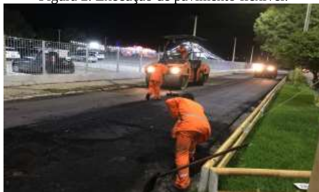
Figura 2. Execução de pavimento flexível.
