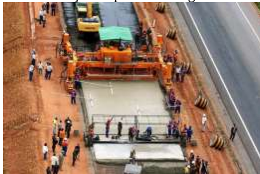
Figura 3. Execução de pavimento rígido em concreto
