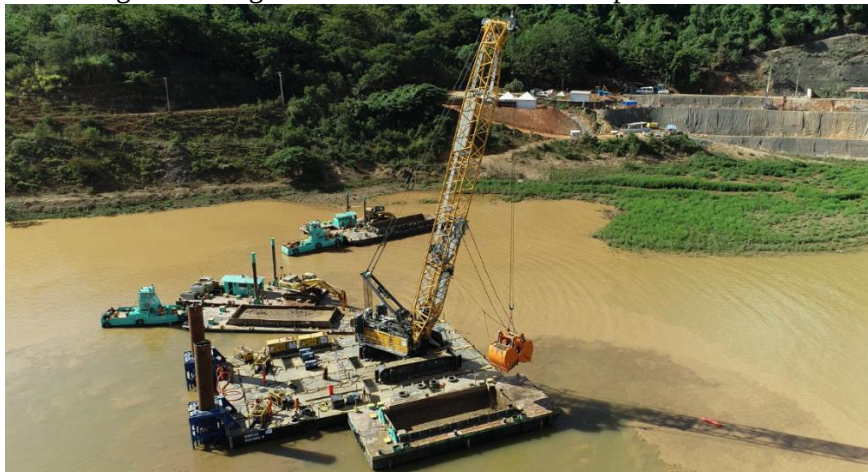
Figura 3. Dragagem clamshell sobre balsa com apoio de batelão
