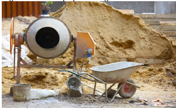
Figura 1: Local de preparo da argamassa com betoneira
