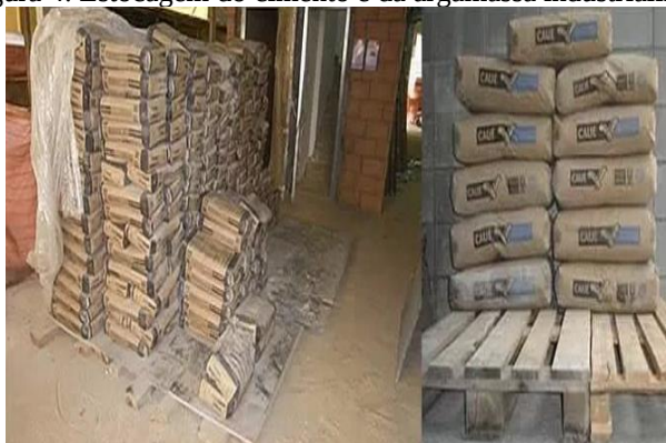
Figura 4: Estocagem do cimento e da argamassa industrializada
