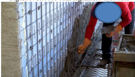
Figura 9. Reboco com argamassa estrutural
