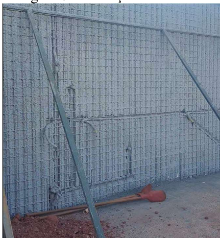
Figura 7: Instalação das escoras
