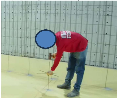
Figura 3. Marcações e instalação dos arranques
