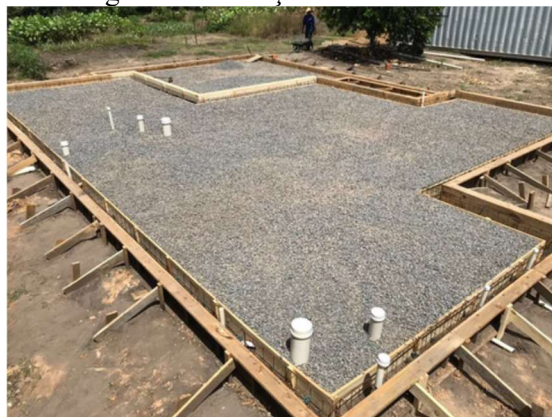
Figura 2. Instalação hidro sanitária
