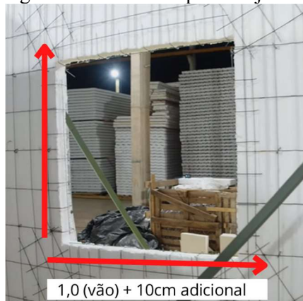
Figura 5. Abertura de portas e janelas
