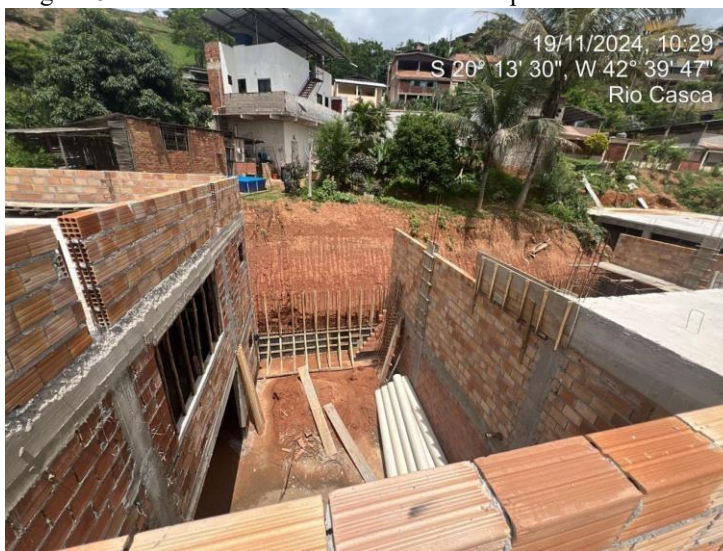
Figura 8- Vista frontal do talude através do 2º pavimento da creche
