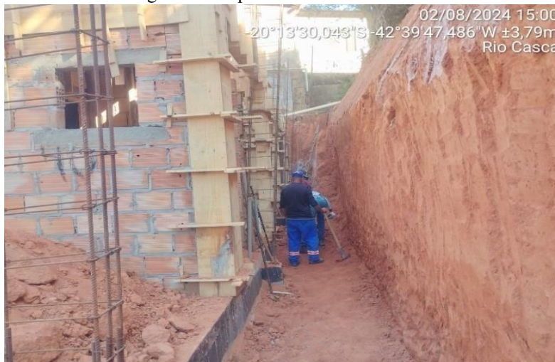
Figura 5- Limpeza do terreno
