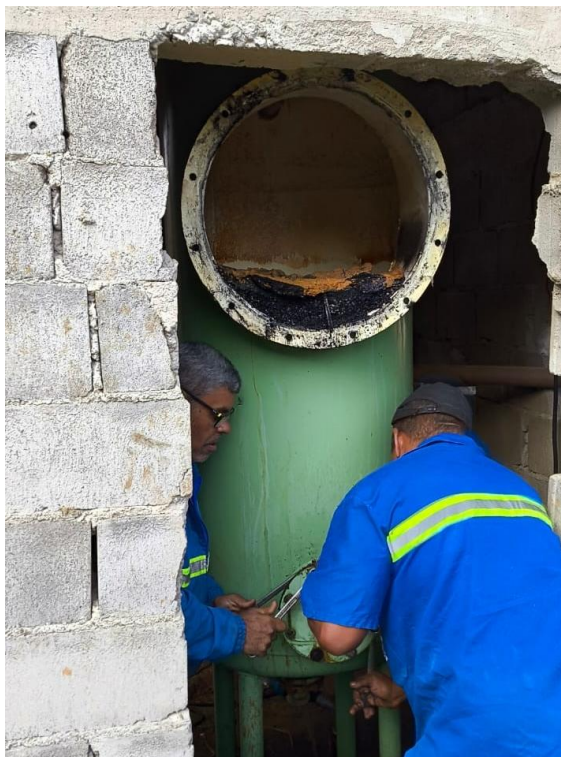
Figura 4 – Colaboradores do DMAES realizando a substituição do carvão ativado por zeólita
