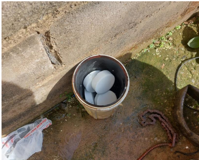
Figura 2 - Pastilhas de tricloro utilizadas na pré-oxidação da água do poço artesiano da comunidade Santa Helena
