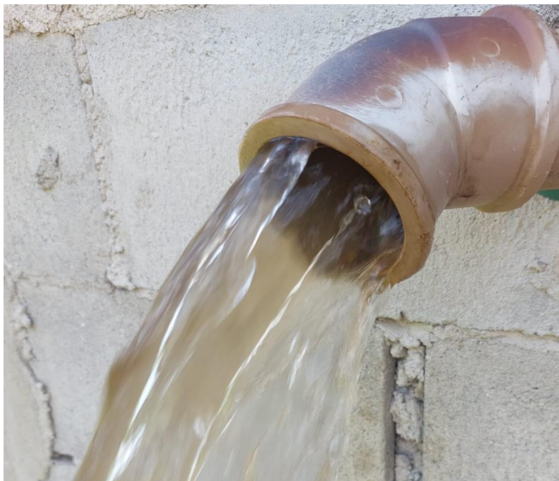
Figura 9 – Água com impurezas resultantes do processo de retrolavagem
