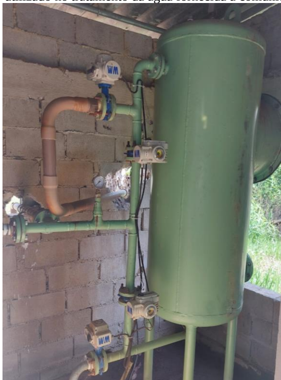
Figura 3 – Filtro utilizado no tratamento da água fornecida à comunidade Santa Helena
