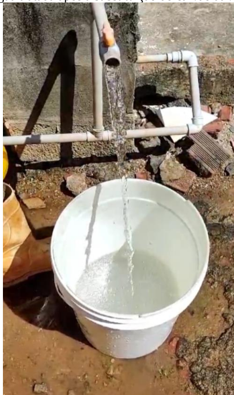
Figura 8 - Água tratada após a substituição do carvão ativado por zeólita
