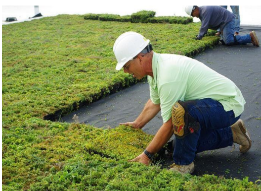
Figura 9- Aplicação de cobertura verde
