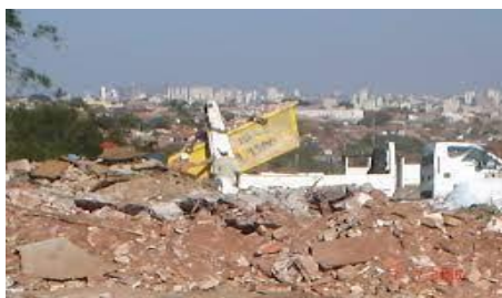
Figura 1- Poluição visual causada pela construção civil
