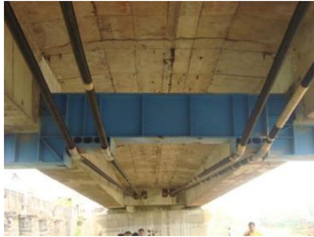
Figura 9 – Protensão externa por duto para reforço de viga longarina
