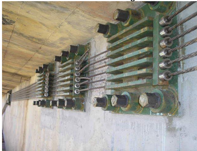
Figura 5 - Dispositivos utilizados para a ancoragem das cordoalhas nas extremidades da viga
