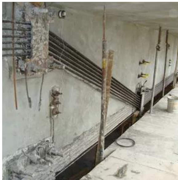
Figura 4 – Desviador superior e inferior na viga
