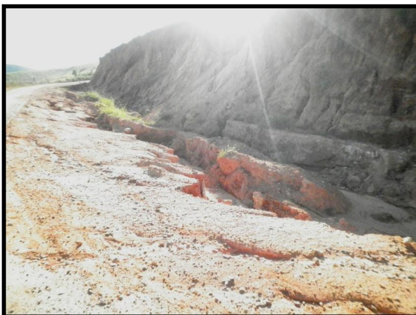
Ilustração 2 - Erosão 1 nas estradas de acesso às granjas.
