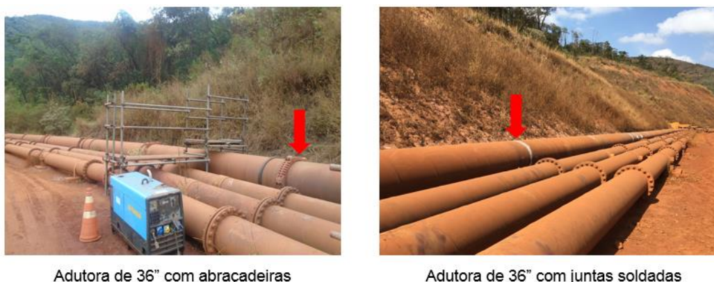
FIGURA 2 – Adutora antes e depois da troca da abraçadeira. Fonte: Autora (2017)
