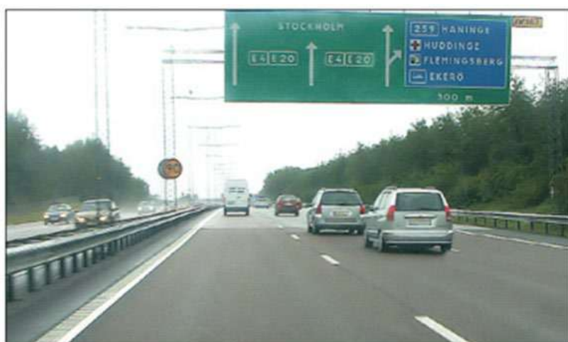
Figura 1- Dupla camada de pavimento poroso em estrada na Suécia – tempo chuvoso sem neblina característica atrás dos veículos.
