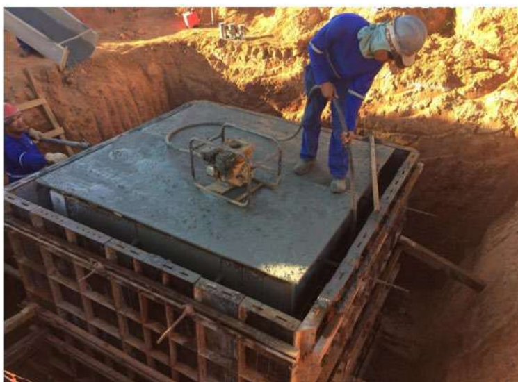
Figura 7 - Vibração do concreto
