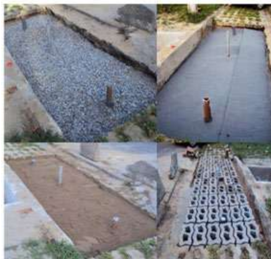
Figura 5 - Concreto permeável em diferentes estágios de construção na área experimental de Recife.
