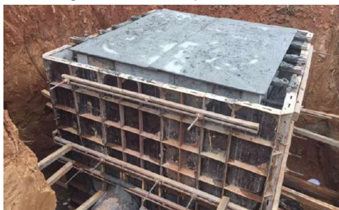
Figura 6 - Fôrma com painel metálico
